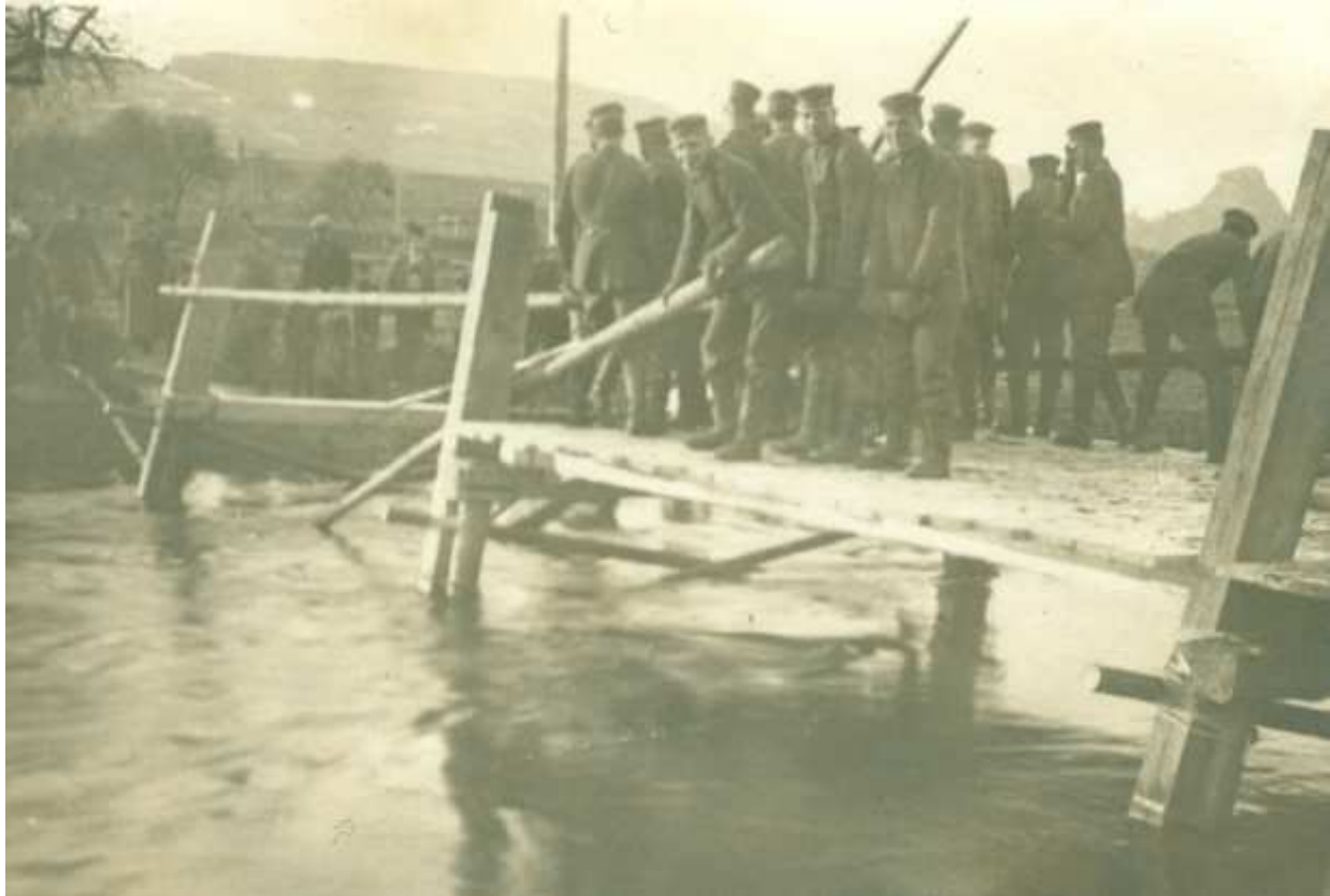
Der Brückenbau über die Aach war eine frühe Notstandsarbeit im Jahr 1915 (Stadtarchiv Singen, 700 Fotosammlung)
