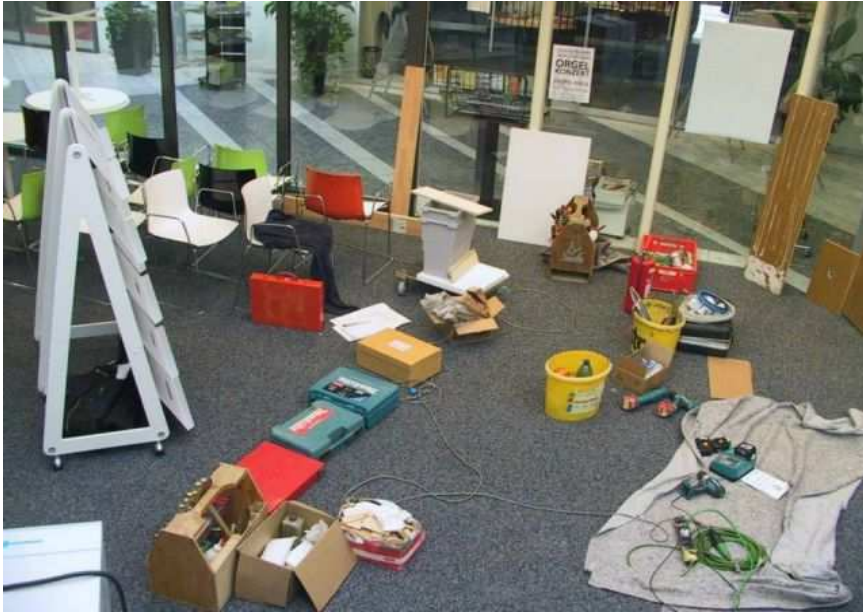
Baustelle Städtische Bibliotheken
